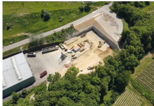
Luftbild der Baustelle, aufgenommen von einer Drohne am 15. Juni 2021
